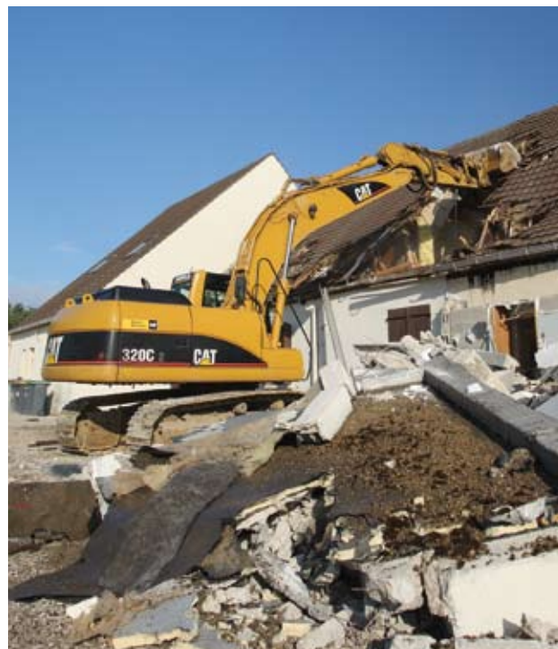
Démolition du bâtiment central, le vendredi 13 juin 2008
